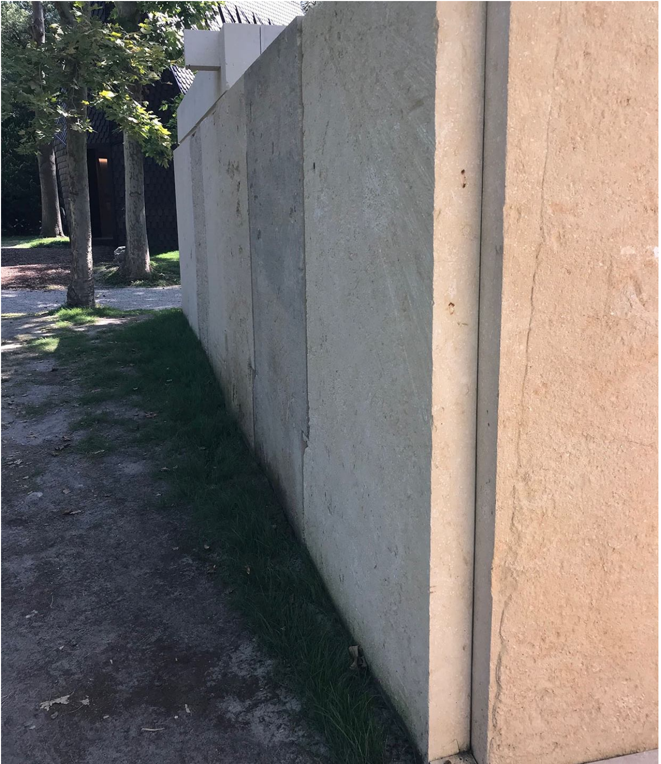
Fig. 3 - L'attacco a terra del sistema costruttivo a secco della Vatican Chapel , Souto de Moura, Biennale di Architettura, Venezia, 2018. Fonte: foto di S. Rugino.
